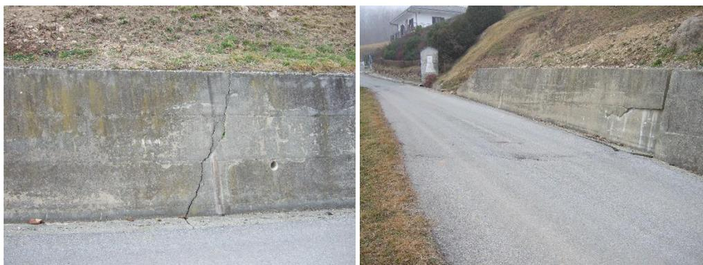
*Figura 12 – Indizi di movimento lungo la strada che conduce a Belice – Pian delle Vasche, presso Strole (Comune di Chiesanuova).*
