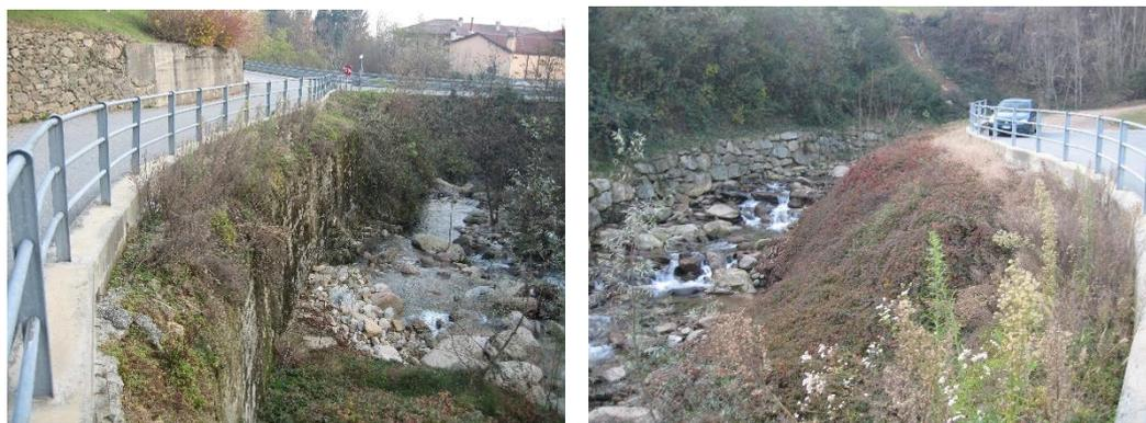
Foto 2: opere di difesa spondale a monte del ponte sulla SP 45: foto a destra STRIDS004 (muretto) e STRIDS004 (gabbioni coperti da vegetazione), da valle; foto a sinistra STRIDS005 (muro) da monte.
