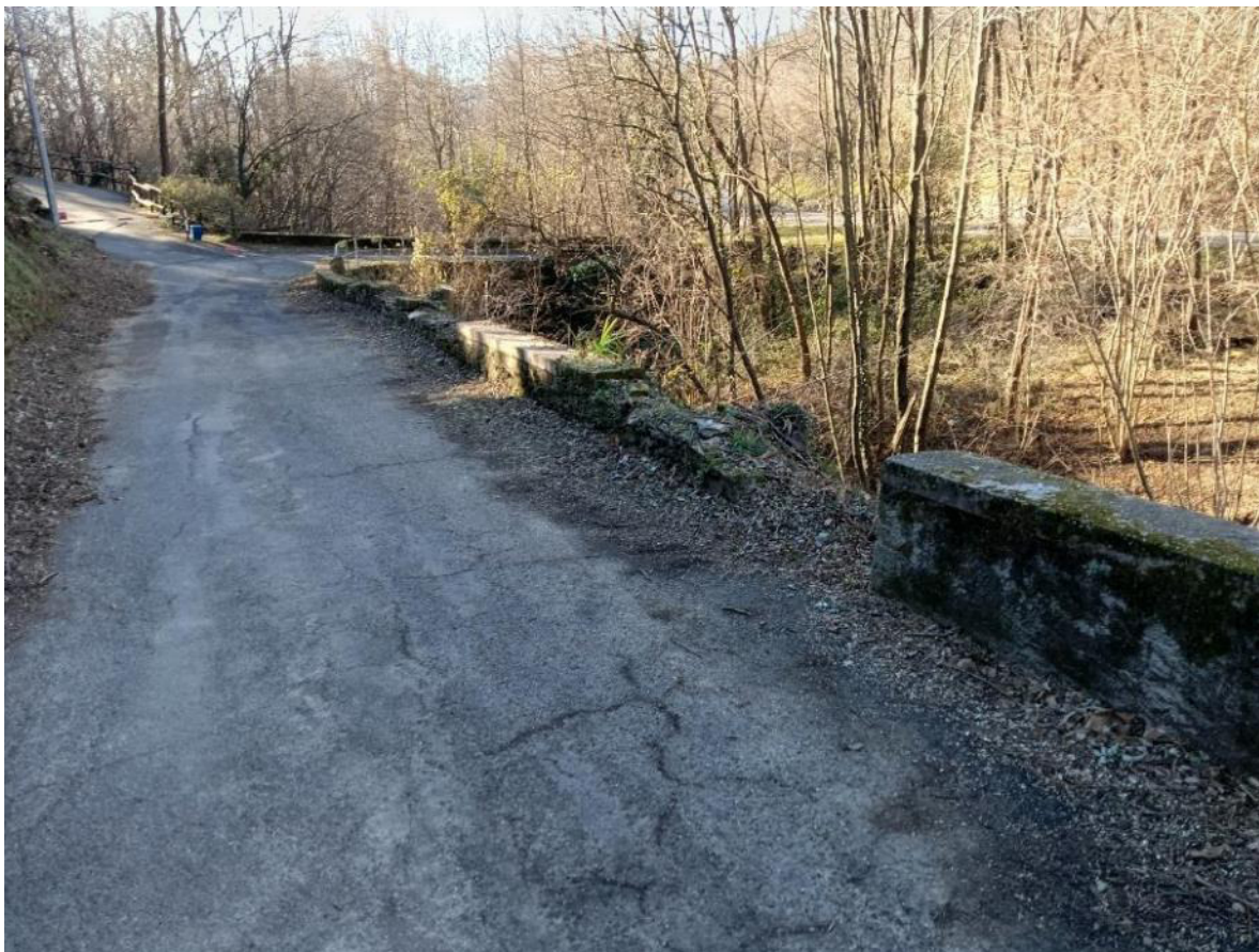
Figura 4: Vista stato attuale dell'area di intervento 2 - ripristino parapetto in pietra esistente con barriera in acciaio corten a due tubi su cordolo in c.a. e asfalti oggetto di variante – Località Pianezze. Rilievo del 19/12/2023
