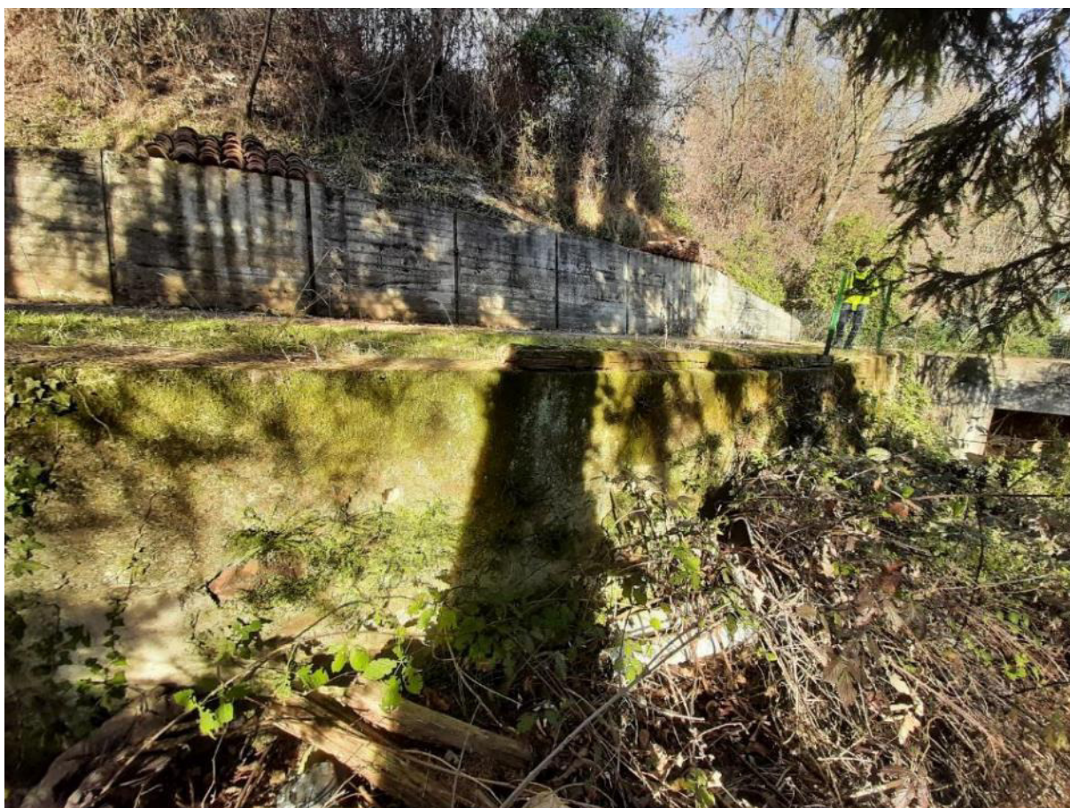
Figura 14: Vista 2 stato attuale dell'area di intervento 13 (EX. INT.11 del PFTE autorizzato) – ripristino muro di sottoscarpa in c.a. esistente oggetto di variante – Via Santa Elisabetta. Rilievo del 29/01/2024
