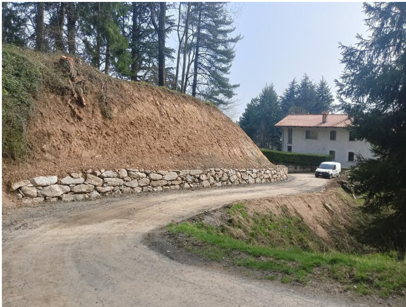
Figura 15: Vista stato attuale dell'area di intervento 16 (EX. INT.13 del PFTE autorizzato) – sistemazione versante in frana e realizzazione scogliera in massi di cava a secco come da progetto esecutivo autorizzato – Strada Antica delle Vigne.
