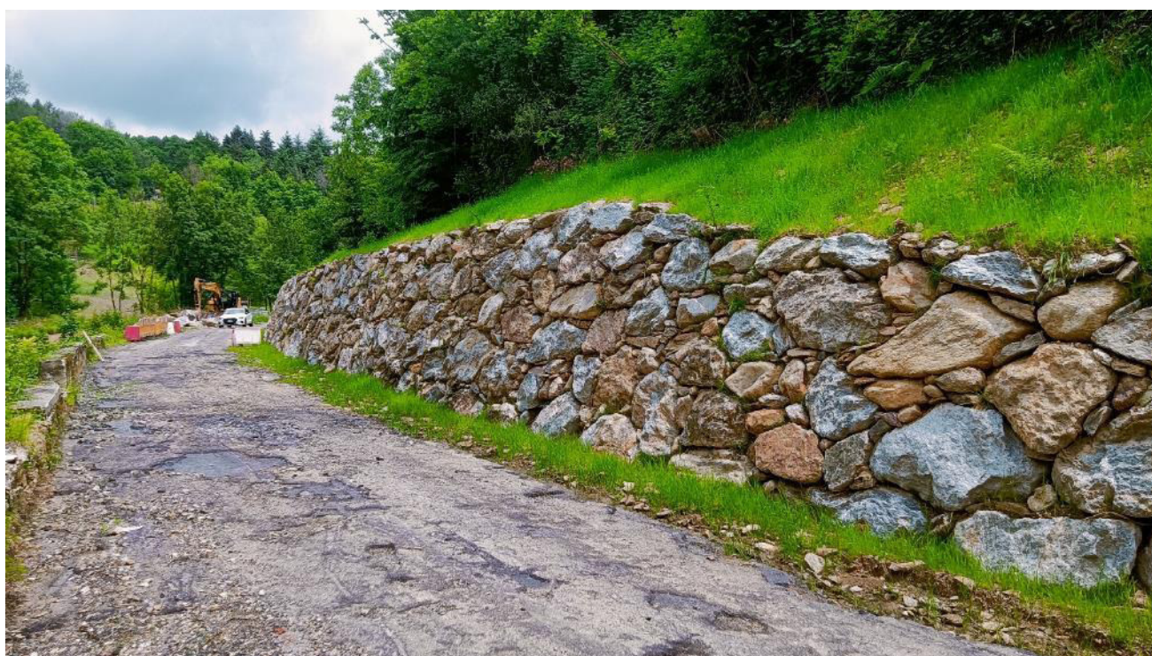
Figura 3: Vista stato attuale secondo tratto dell'area di intervento 1 - scogliera di controripa a secco realizzata come da progetto esecutivo autorizzato – Località Pianezze.
