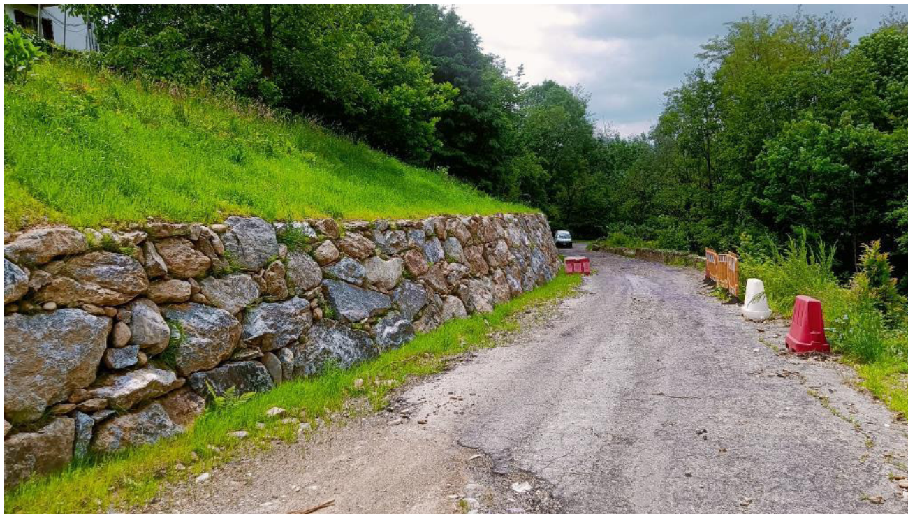
Figura 2: Vista stato attuale primo tratto dell'area di intervento 1 - scogliera di controripa a secco realizzata come da progetto esecutivo autorizzato – Località Pianezze.
