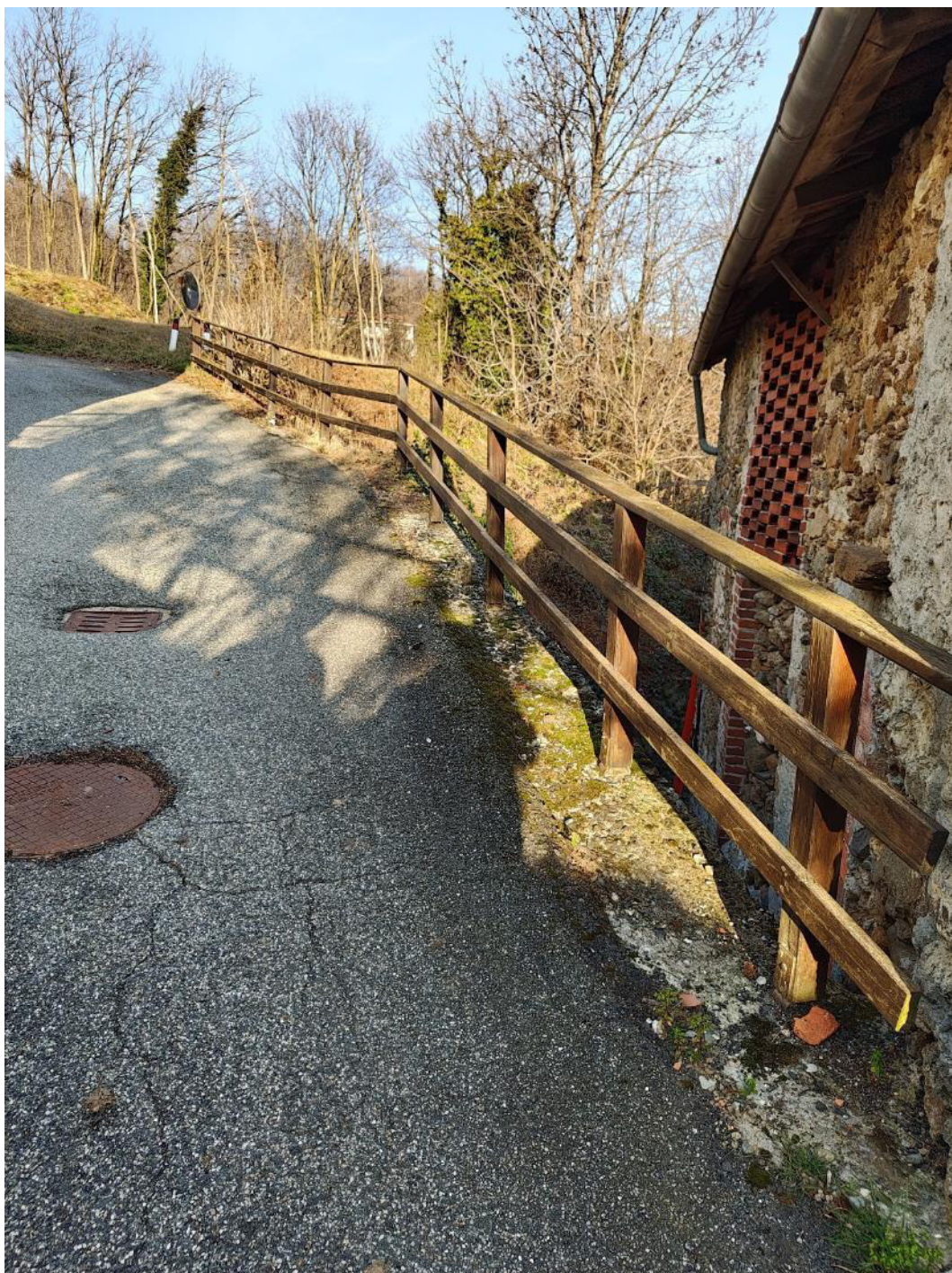
Figura 10: Vista stato attuale dell'area di intervento 12 (EX. INT.10 del PFTE autorizzato) – sostituzione staccionata in legno con installazione parapetto a tre tubi passanti in acciaio zincato su nuovo cordolo in c.a. oggetto di variante – Via Santa Elisabetta. Rilievo del 29/01/2024
